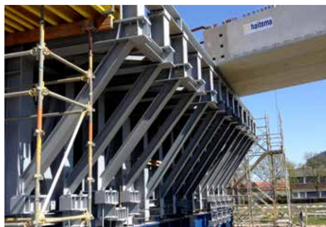
De galgconstructie heeft een tijdelijke functie en draagt de liggers totdat de kolomstrook gestort en uitgehard is.
