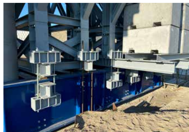
Detailaansluiting galgconstructie op PRS-ligger.
