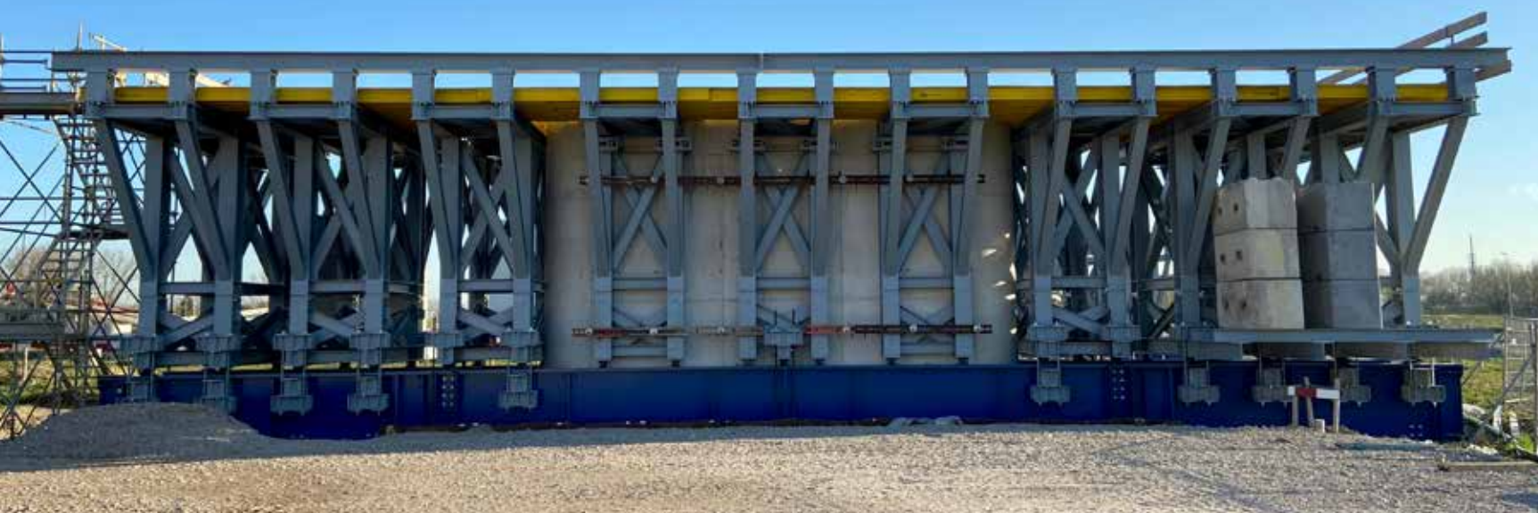
Zijaanzicht tijdelijke galgconstructie rondom pijler.
