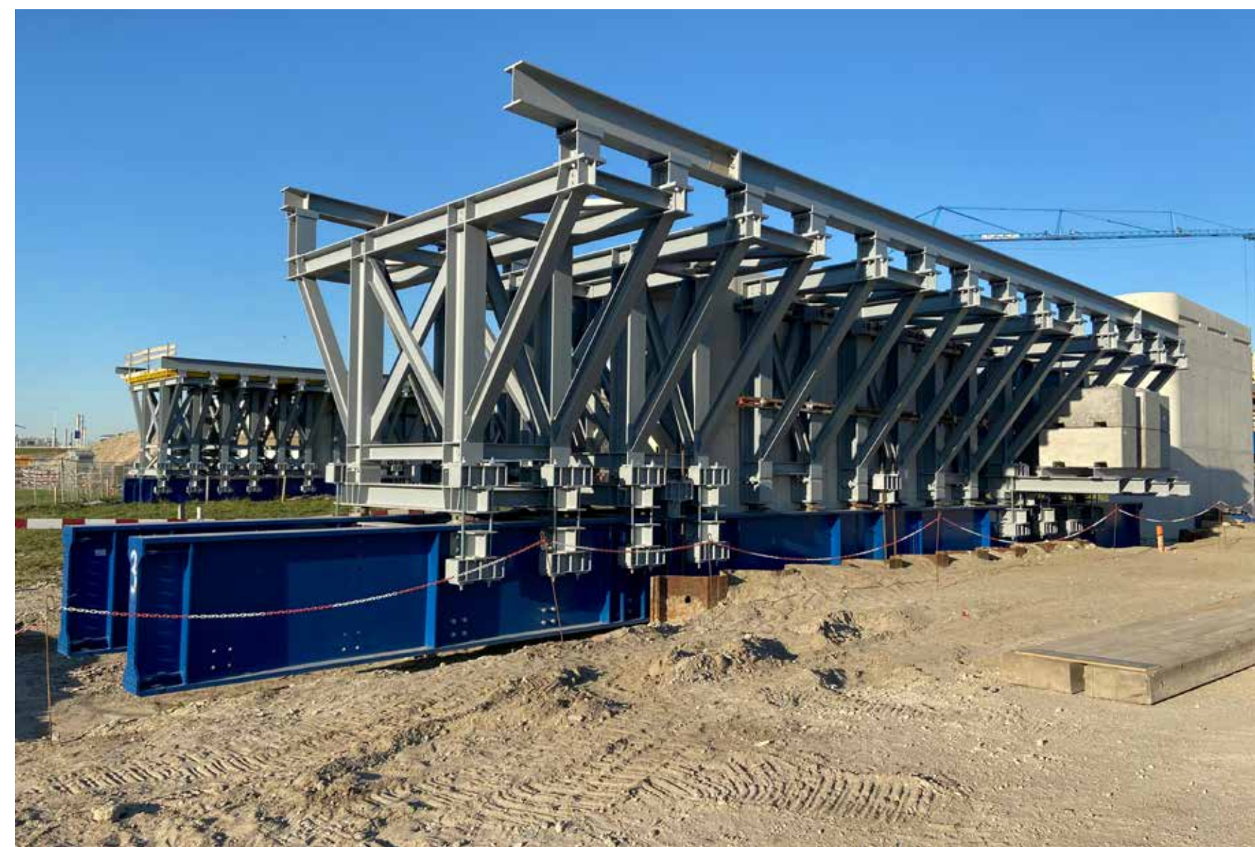
In totaal gaat er zo'n 290 ton staal door de handen van Ferross Staalbouw gedurende anderhalf jaar.
