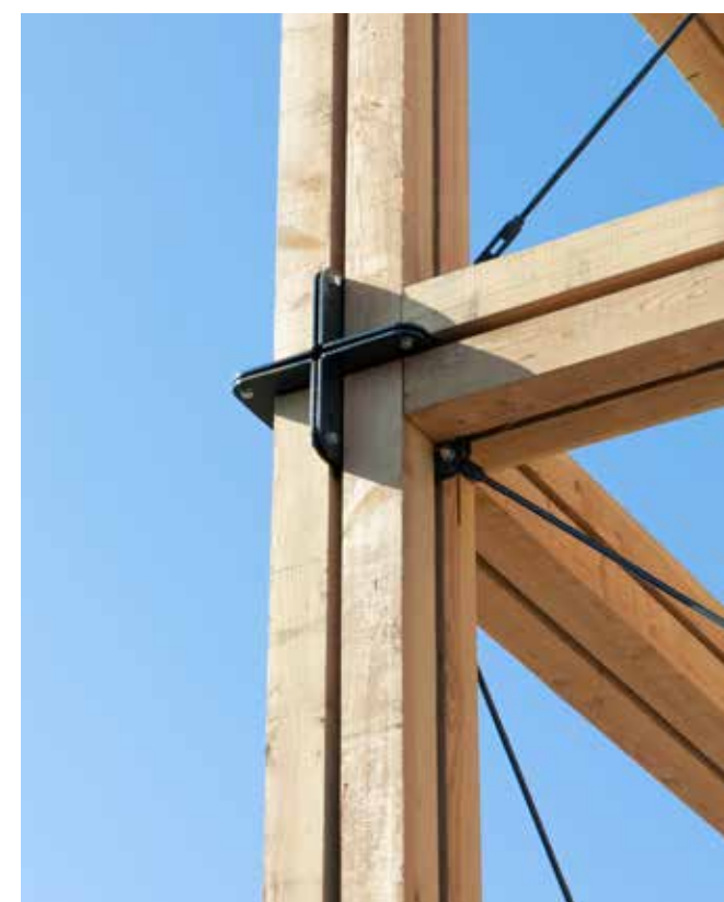
Stalen knooppunten, gelast door de lasrobot.
